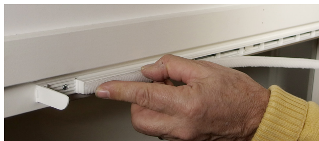
Venttiilin kausiasentosäädin
